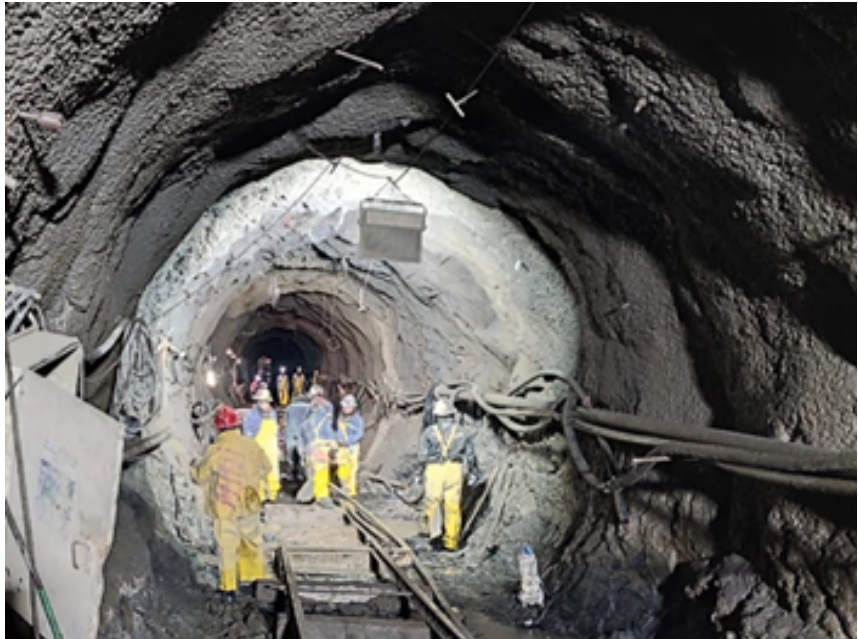
Avance de obras Túnel 1.
