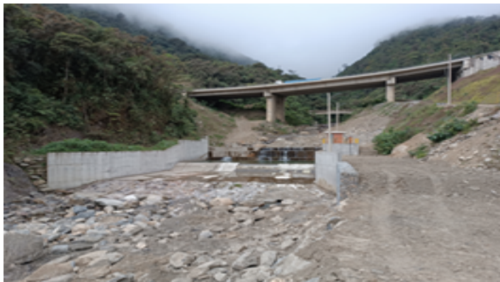
Obras concluidas del proyecto.
